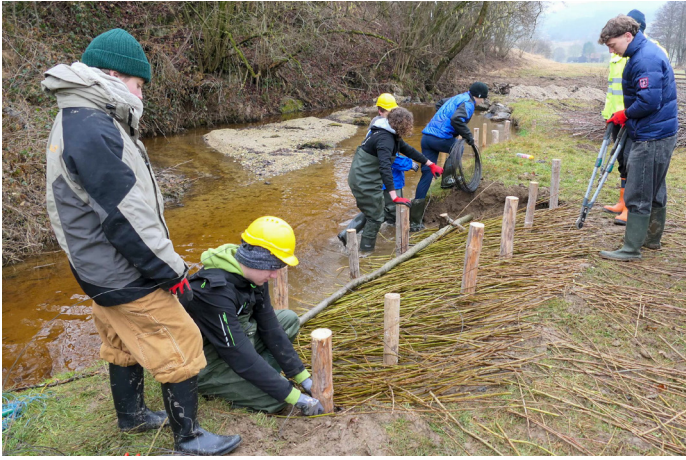
Ingenieurbiologische Ufersicherung in Bau; Foto: WLV
