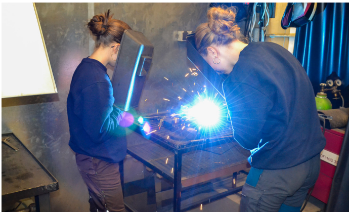
Franziska und Nicole bei der Durchführung von Schweißarbeiten
